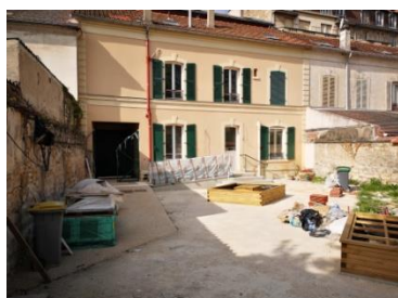
Les accès praticables par les personnes à mobilité réduite sont terminés.
